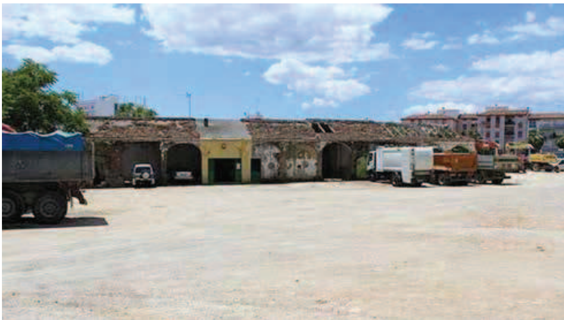
Terrenos en los que se construirá la biblioteca. Vanessa Melgar
